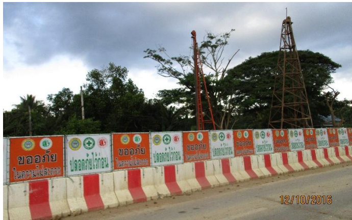
กำหนดขอบเขตพื้นที่ก่อสร้าง
